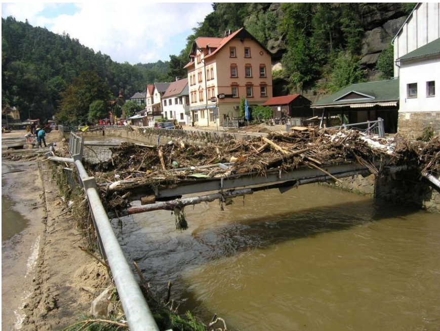
Hřensko, po bleskových záplavách, 2010 Autor foto: HZS Ústeckého kraje
